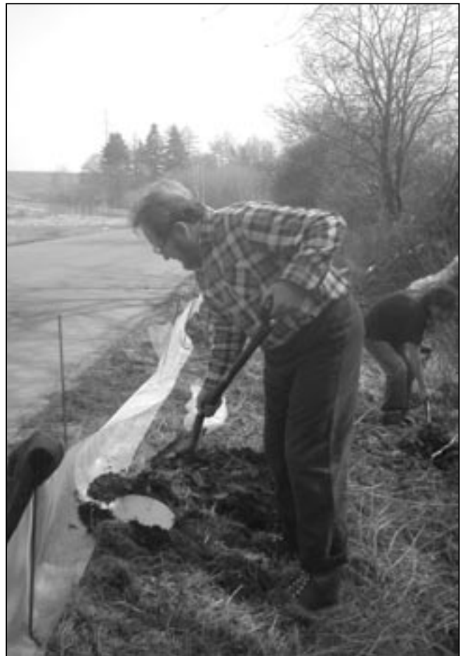
Instalace sběrných nádob na lokalitě Trhový Štěpánov.
