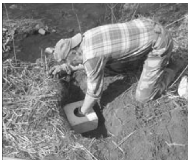
Instalace umělé nory pro ledňáčky.
