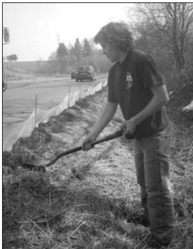
Upevnění sítě k zemi na lokalitě Trhový Štěpánov.
