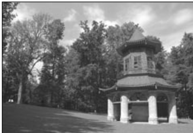
Čínský pavilon před rekonstrukcí.
