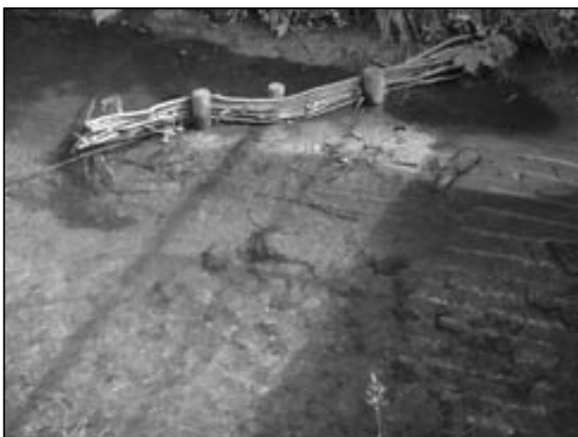
Dřevěné výhony na Račím potoce zvyšují variabilitu dna
