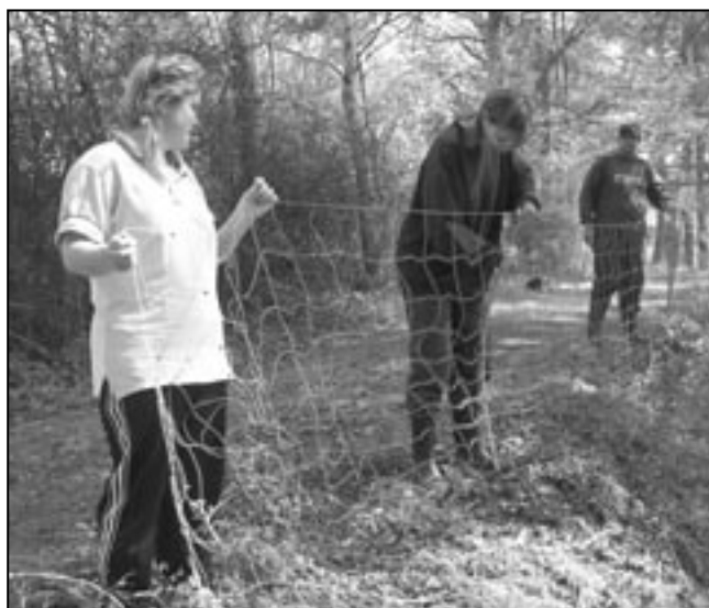
Stavba síťového oplocení pastviny.
