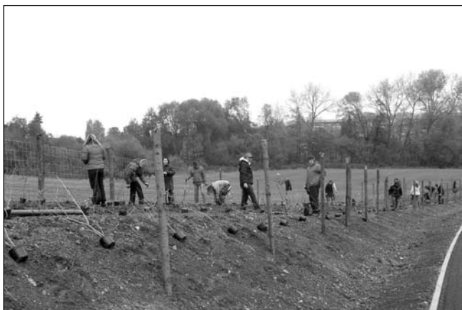
Dobrovolníci z řad Českomoravské stavební spořitelny sází remíz v Řičanech u Prahy. foto: M. Lempochner
