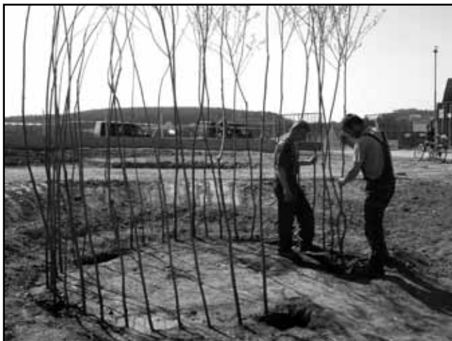
Zakládání vrbové chýše v areálu nové MŠ Vorlina ve Vlašimi.
