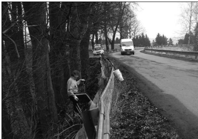
Stavba zábran na lokalitě Šternov.
