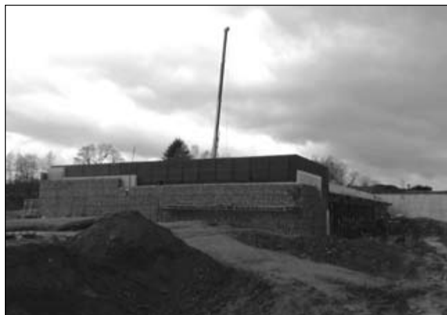
Fasádu Vodního domu budou ze tří stran tvořit gabionové sítě vyplněné hadcovou drtí. Jedná se o lokální surovinu, protože hadec je typickou horninou této oblasti.
