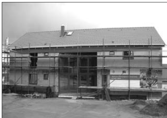
Hrubá stavba nového ubytovacího zázemí v Podblanickém ekocentru. foto: J. Pavelka
