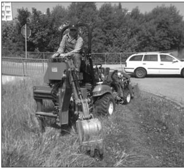
Výkop jam pro nové výsadby pomocí podkopu.
