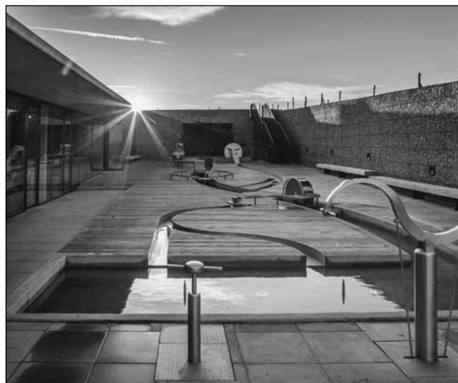
Vodní dům – hlavní vstup a atrium za soumraku.
