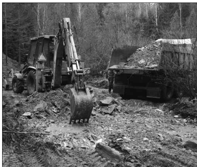
Hloubení tůní probíhalo za pomoci těžké techniky.
