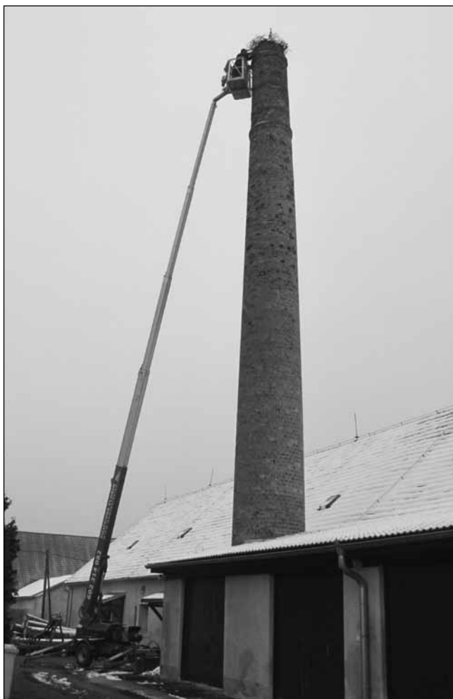
Instalace hnízdní podložky na komín lihovaru Zátíší. foto: M. Kloudys
