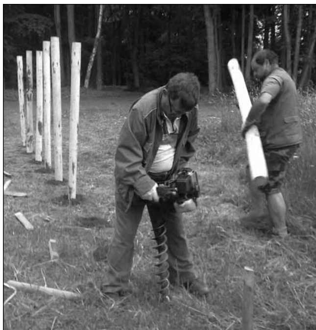
Tvorba opěrné konstrukce v rámci projektu Rekonstrukce zámeckého parku v Ratměřicích.
