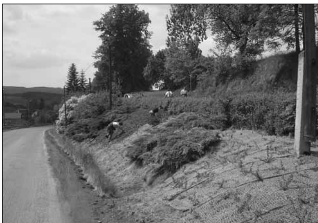
Osázení stráně v rámci projektu Rekonstrukce zeleně v Křivsoudově.
