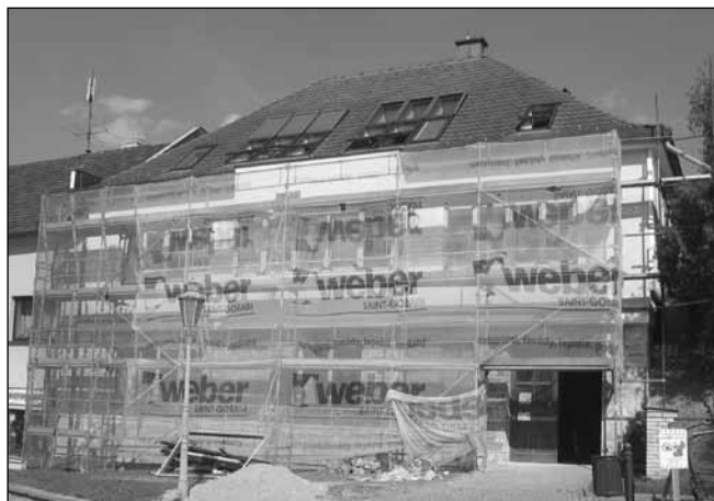
Zateplením fasády a výměnou starých špaletových oken jsme dosáhli znatelného zlepšení tepelně izolačních vlastností budovy ekocentra. foto: B. Hozová
