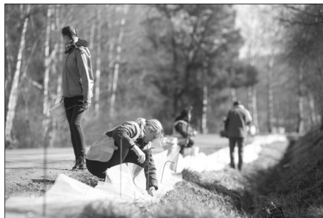
Budování zábran pro obojživelníky podél komunikace. foto: F. Petrák
